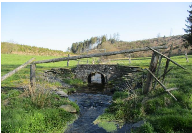
Foto gegen Fließrichtung
