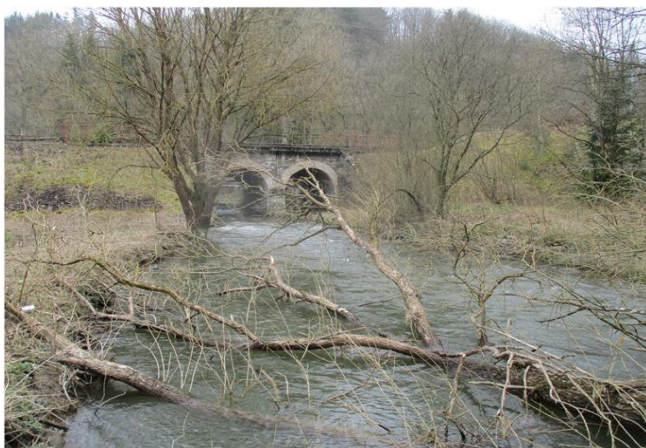
Foto gegen Fließrichtung
