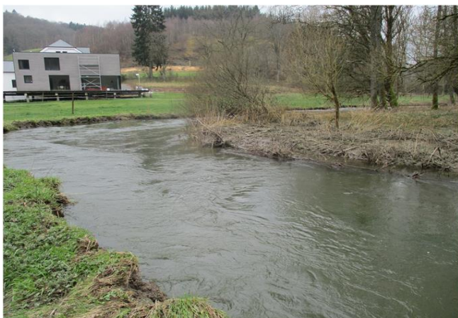
Foto gegen Fließrichtung
