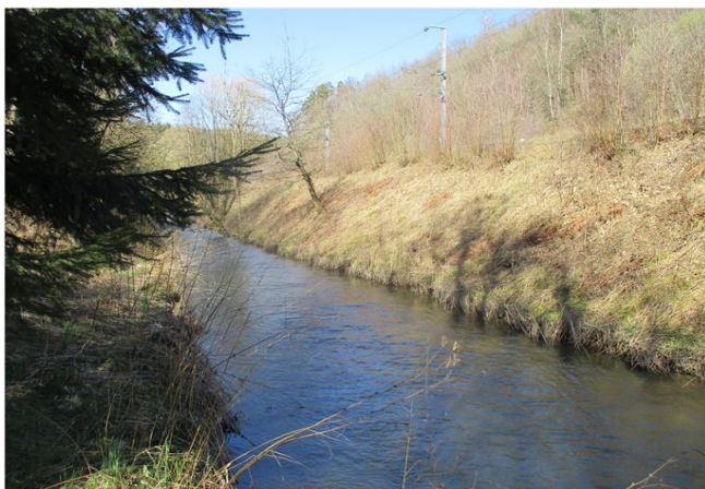
Foto gegen Fließrichtung
