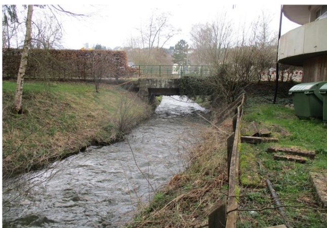
Foto gegen Fließrichtung
