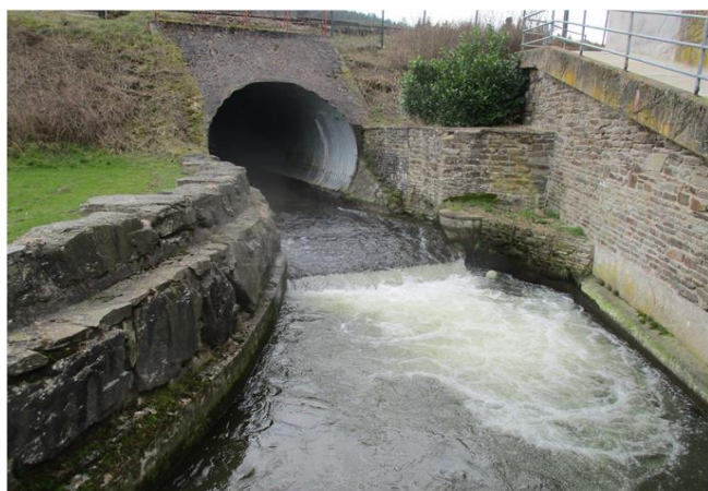
Foto gegen Fließrichtung
