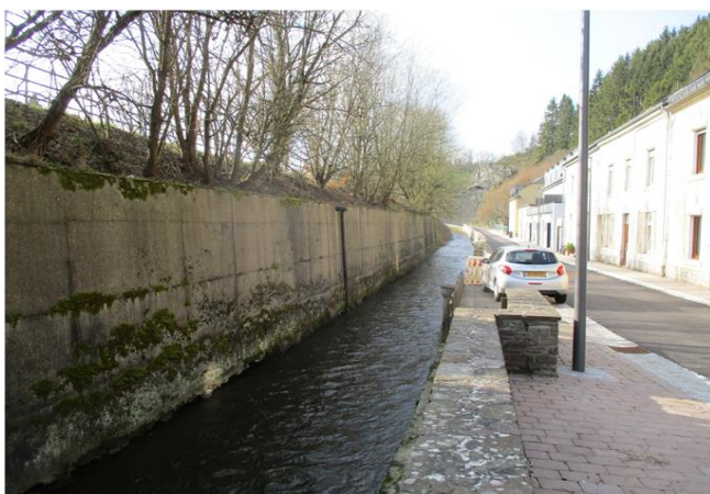
Foto gegen Fließrichtung
