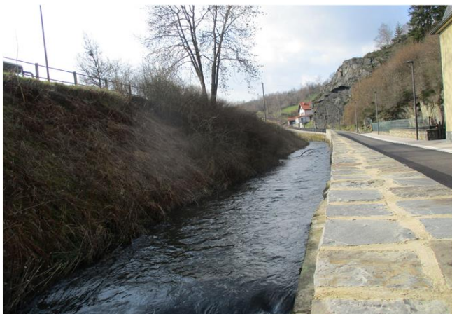
Foto gegen Fließrichtung
