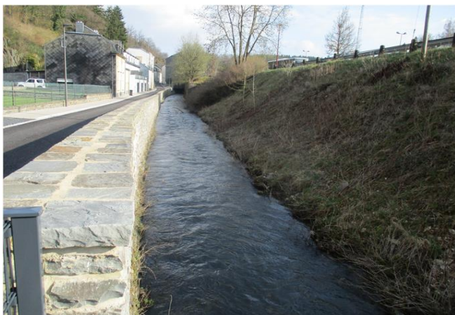
Foto gegen Fließrichtung
