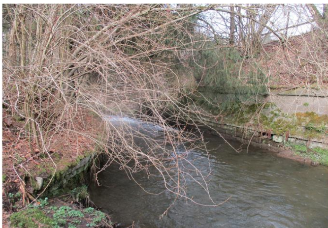
Foto gegen Fließrichtung
