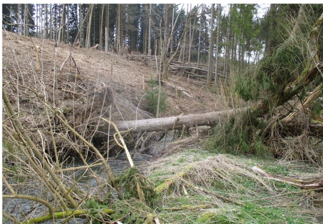
Foto gegen Fließrichtung
