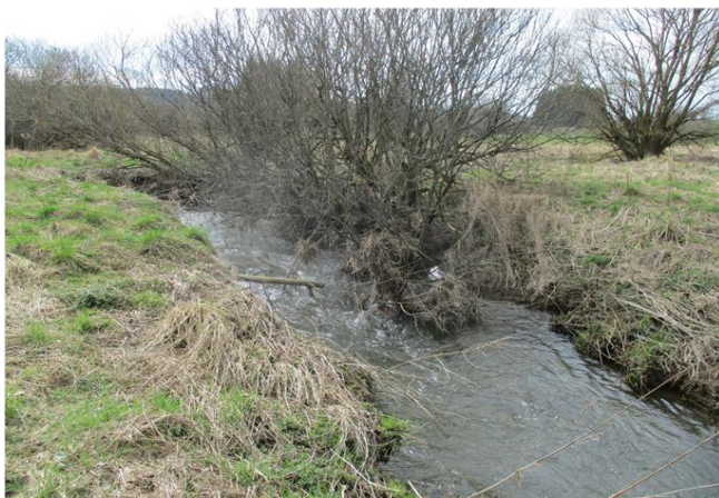
Foto gegen Fließrichtung
