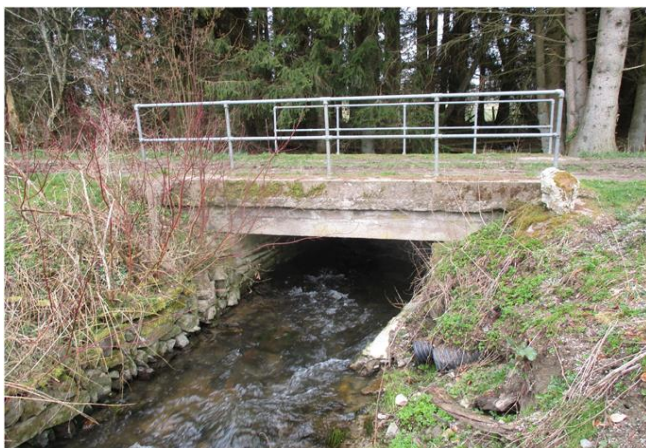
Foto gegen Fließrichtung
