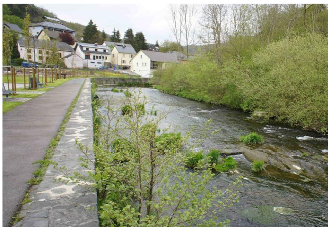
Foto gegen Fließrichtung
