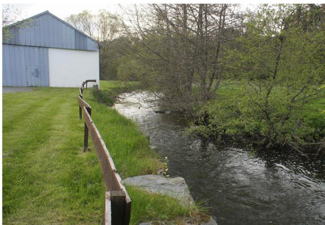
Foto gegen Fließrichtung
