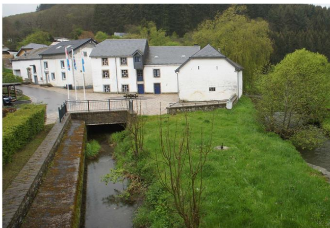
Foto gegen Fließrichtung
