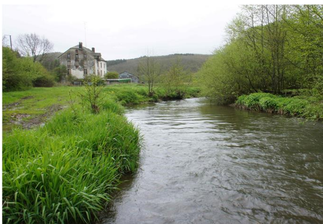
Foto gegen Fließrichtung
