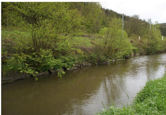
Foto gegen Fließrichtung
