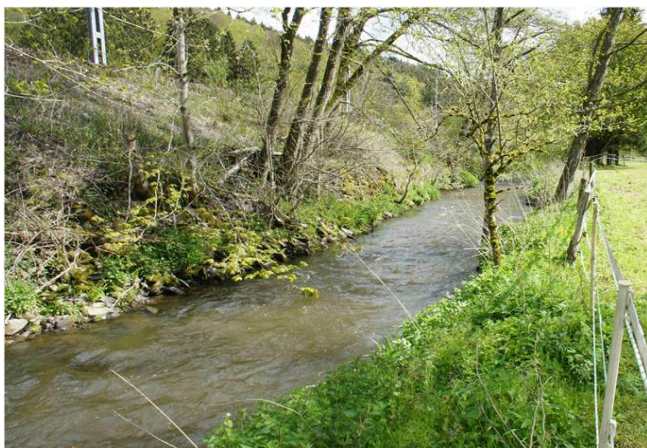
Foto gegen Fließrichtung
