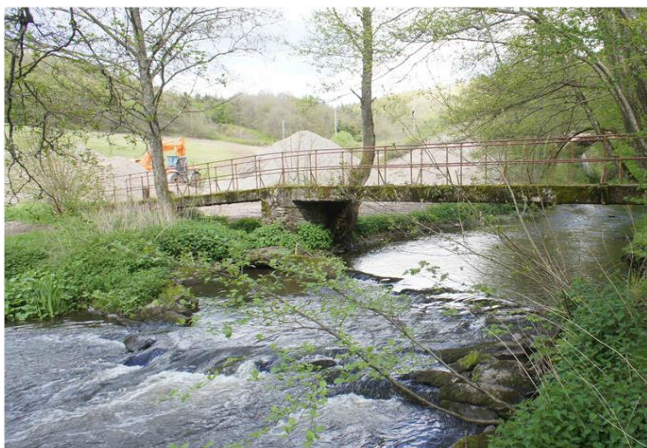
Foto gegen Fließrichtung
