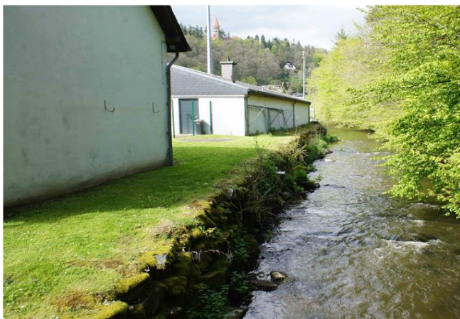
Foto gegen Fließrichtung
