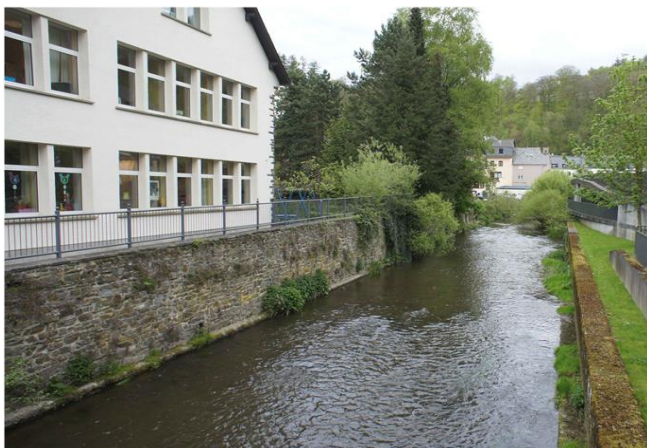
Foto gegen Fließrichtung
