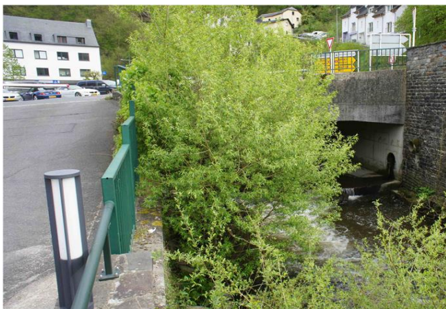
Foto gegen Fließrichtung
