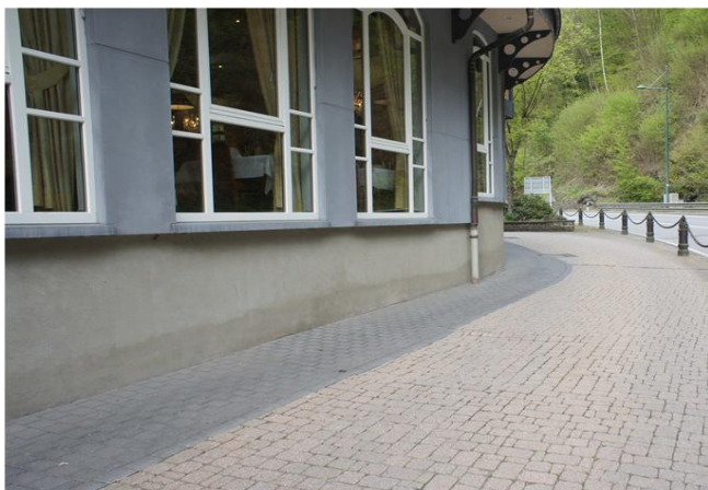
Foto gegen Fließrichtung
