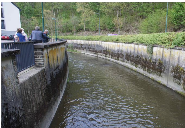
Foto gegen Fließrichtung
