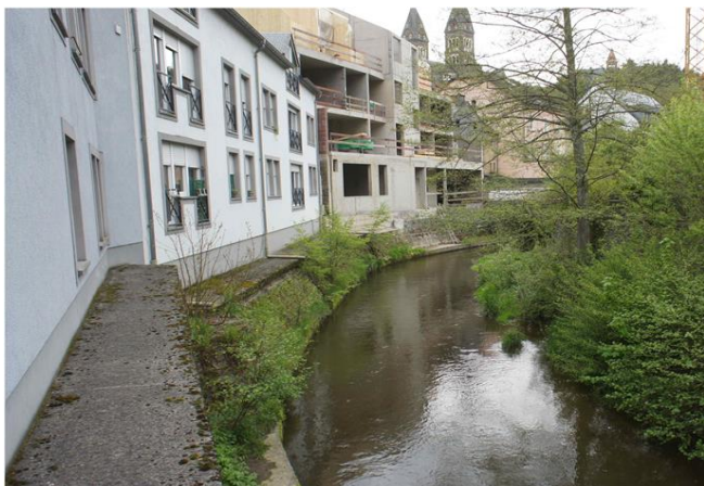
Foto gegen Fließrichtung
