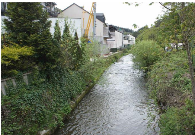
Foto gegen Fließrichtung
