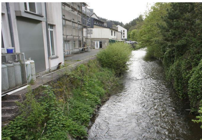
Foto gegen Fließrichtung
