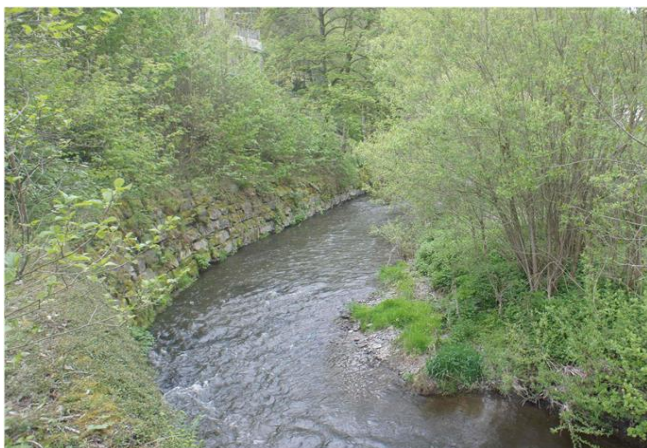
Foto gegen Fließrichtung
