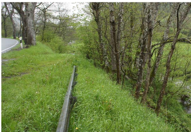
Foto gegen Fließrichtung
