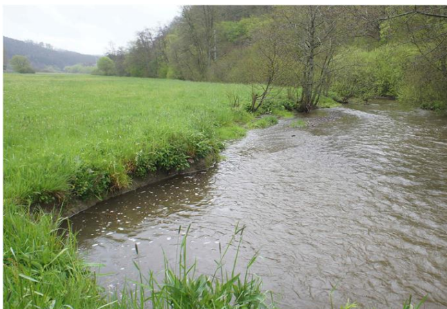
Foto gegen Fließrichtung
