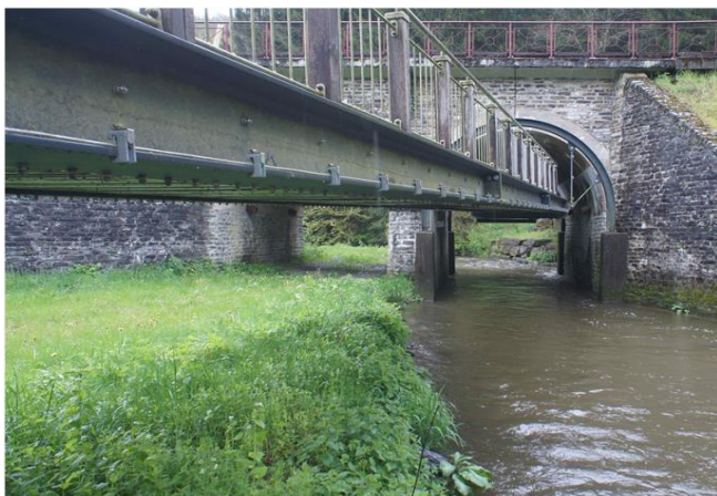
Foto gegen Fließrichtung
