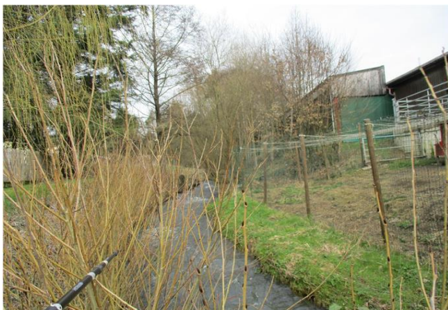
Foto gegen Fließrichtung
