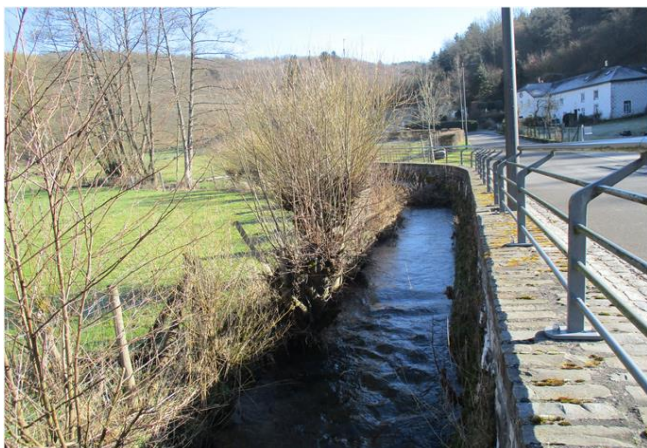
Foto gegen Fließrichtung
