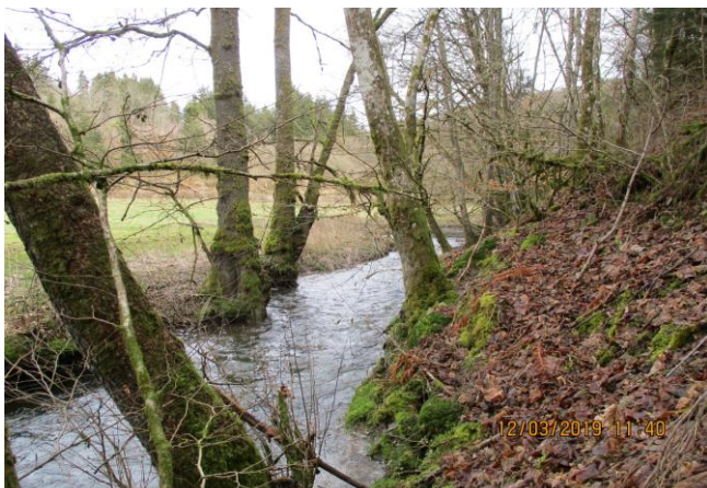
Foto gegen Fließrichtung
