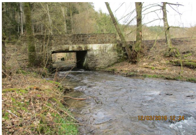
Foto gegen Fließrichtung
