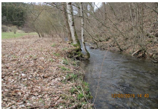
Foto gegen Fließrichtung
