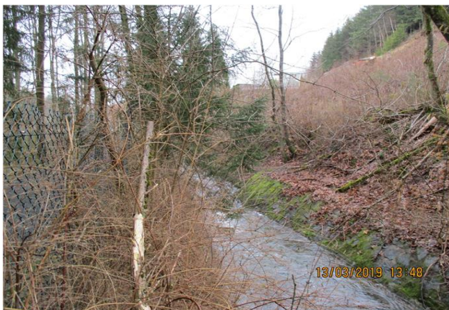
Foto gegen Fließrichtung
