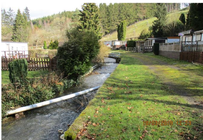
Foto gegen Fließrichtung
