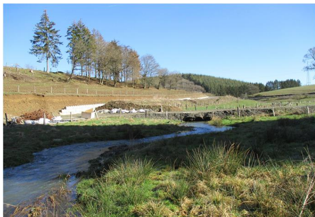
Foto gegen Fließrichtung
