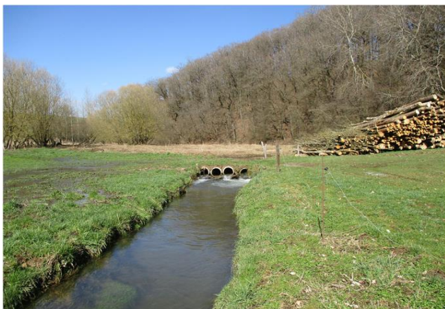
Foto gegen Fließrichtung
