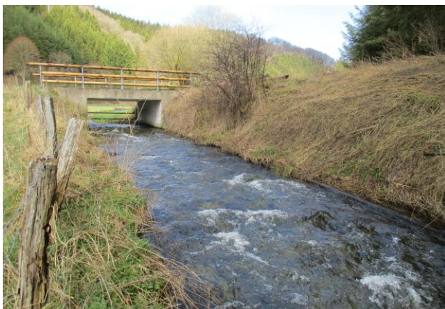
Foto gegen Fließrichtung
