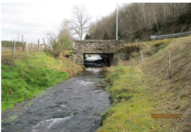
Foto gegen Fließrichtung
