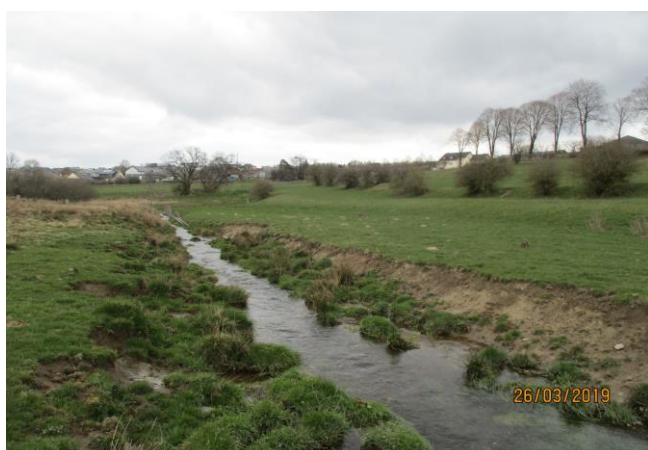
Foto gegen Fließrichtung
