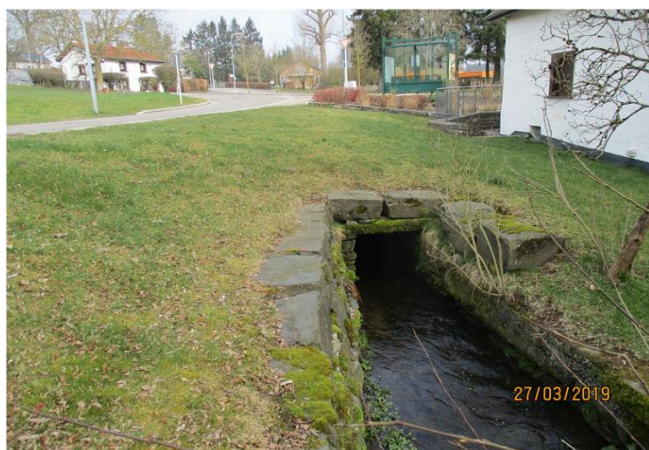
Foto gegen Fließrichtung
