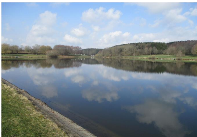
Foto gegen Fließrichtung
