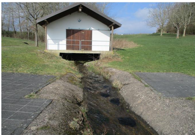
Foto gegen Fließrichtung
