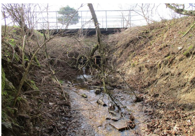
Foto gegen Fließrichtung
