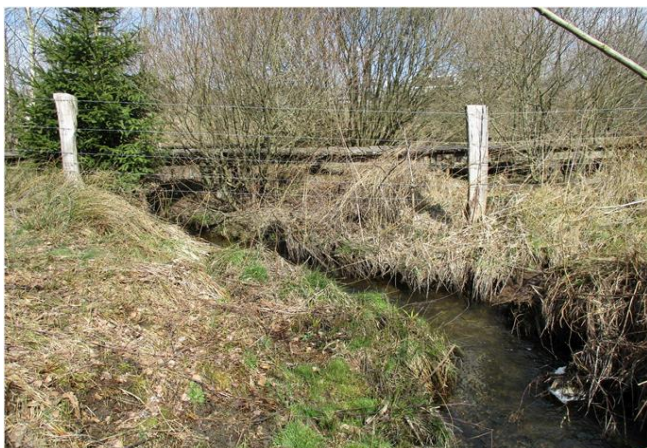
Foto gegen Fließrichtung
