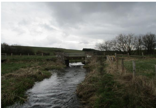
Foto gegen Fließrichtung
